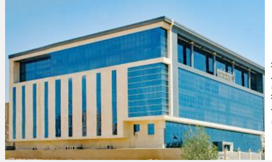
مبنى النيابة العامة
