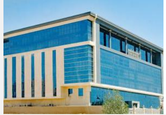
مبنى النيابة العامة
